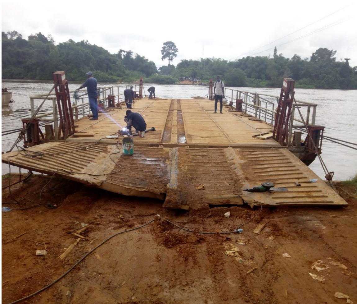
Travaux de réfection du Bac servant à la traversée des convois de rapatriement du Libéria, dans le sud-ouest du pays (Prollo) © UNHCR
